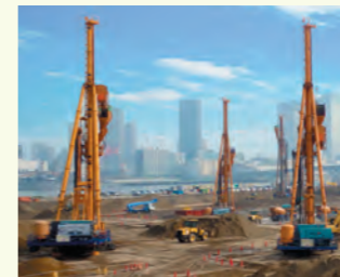
弱い地盤を強くする地盤改良技術
