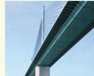
福岡のまちを支える都市高速道路の橋
