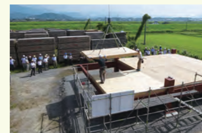
木材を床の構造材に用いた場合の問題点把握のための施工実験
