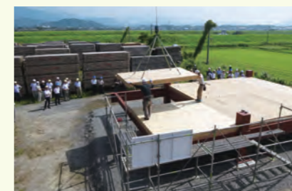
木材を床の構造材に用いた場合の問題点把握のための施工実験
