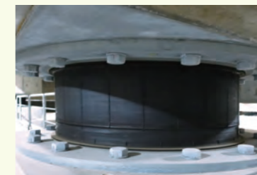
免震構造の積層ゴムの研究は、福岡大学が日本で最初だって知っていました?
