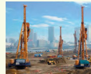
弱い地盤を強くする地盤改良技術
